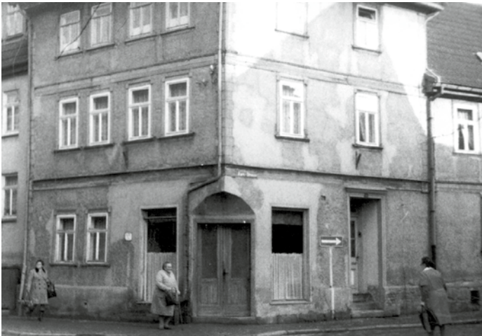
Vor dem Abriss 1980
