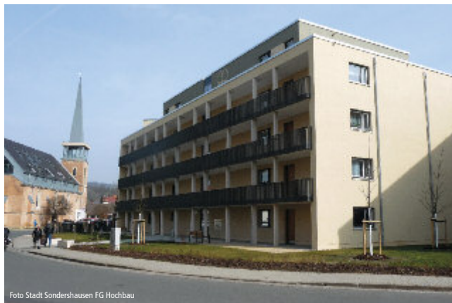
Wohnhaus der WBG „Glückauf“ am Planplatz 11
