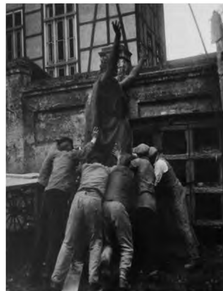
Abbruch des Fürstenbrunnens
