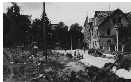
Zerstörter Lohbrunnens in der Güntherstraße
