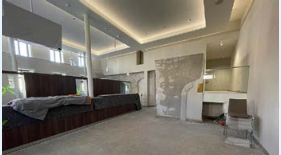
Eingangsbereich – Empfang und Bürgerbüro
