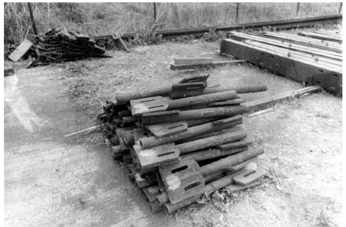
Durch dieses konnte der schnellbindende Spezialbeton in das Mauerwerk verpresst werden und so eine stabile Verbindung zwischen der Schachtwandung und dem Stalleinbau gewährleistet werden. Dabei stand aber erst einmal die Frage, ob diese Ein-Ankervariante die gleiche Sicherheit bietet wie die Doppelausführung. Deshalb wurden in dem Versuchsschacht „Glückauf 4a“ Klop- und Rüttelversuche dazu durchgeführt und die neue Einbaumöglichkeit bestätigt.
