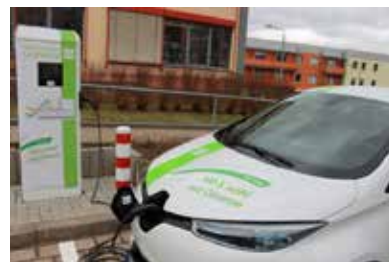
Bild: Normalladesäule PP SWS/Bibliothek
