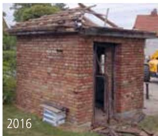
Das Pumpenhaus, welches sich 2016 noch in einem sehr desolaten Zustand befand, bekam einen neuen Dachstuhl mit Eindeckung, eine neue Tür, neue Fenster, eine neue E-Installation, die Pumpe wurde im Inneren installiert, das Mauerwerk wurde neu verfugt usw. Letzten Endes eine Summe an vielen „Kleinigkeiten“, die aber erst einmal gestemmt werden mussten.
