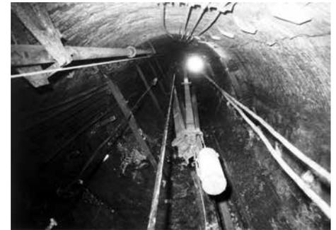
In der Schachtröhre an der Spezialbühne angekommen, wurden vom Dach aus die Spurlatten gespreizt und durch die 16m lange Spezialbühne eingefädelt und auf dem bereits eingebauten Spurlatten-Strang aufgesetzt. Als erstes
