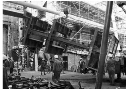
Füllortes begannen mit dem Einbau einer zwei-etagigen Bühne dort die Arbeiten. Parallel dazu montierte SBN Übertage auf der Ackersohle eine 16m lange sechsetagige Spezialbühne. (Bild1)
