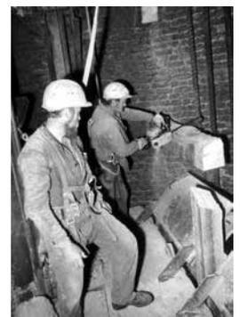
Mit dem erstmaligen Erreichen der technologischen Endteufe der Schachtröhre für die Reko 88 bei 645m musste der Bühnenbelag der K-Strecke gesäubert und die Lote aus der Schachtröhre mit den Lotenden in der K-Strecke verbunden werden.
