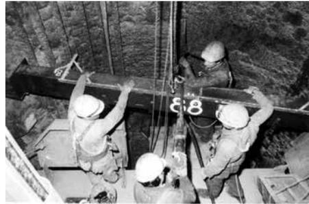
Einstrich und Schuh wurden mit einem Anzugmoment von 250Nm verschraubt. Im anschließenden Arbeitsgang erfolgte die Vermörtelung des Ringsspalt zwischen dem Rohranker des Einstrichschuhs und der Bohrl Lochwandung, in dem durch den hohlen Rohranker die Verpressung erfolgte. Während der Zeit der Abdichtung wurden zum Schacht hin Schaumgummiringe und Schellen verwendet. Als Baustoff wurde ein schnell abbindender Injektions-Mörtel eingesetzt. (Bild6)
