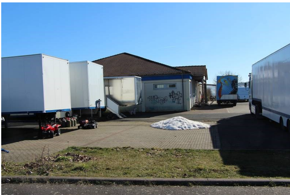
Gebäude des ehemaligen SB-Lebensmittelmarktes an der Straße „Zum Dickkopf“
