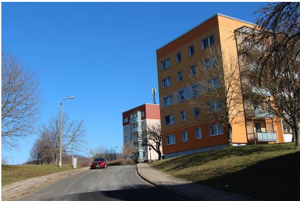
Wohnbebauung an der „Straße des Friedens“ aus Richtung Süden
