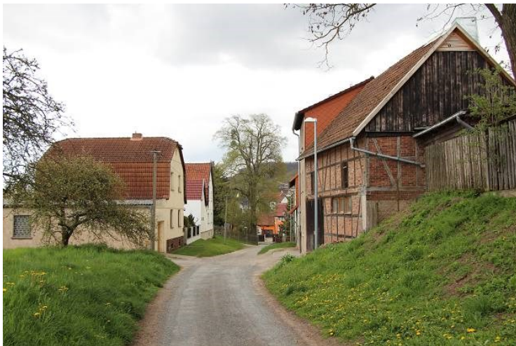
Die vorhandene Bebauung an der Mühlgasse aus Richtung Westen.
