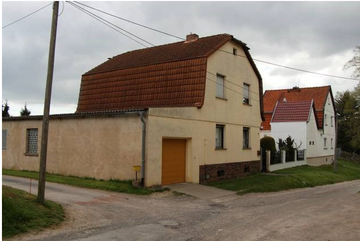
Die Bebauung auf der Nordseite der Straße Mühlgasse 23 und Reitbahn 34.
