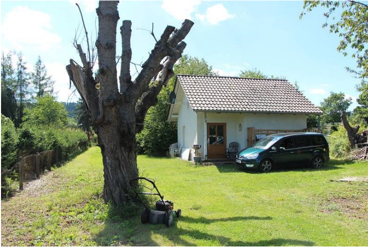
Blick von der Grundstückszufahrt auf das Gartenhaus.
