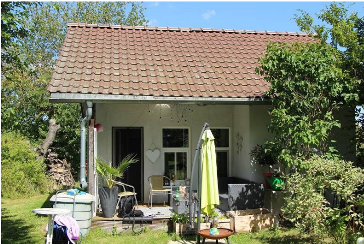
Das Gartenhaus aus Richtung Süden.
