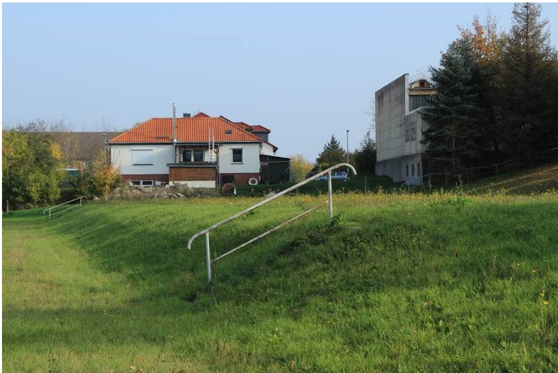
Ehemalige Sport-Freianlagen, Sporthalle und Einfamilienhaus von Westen
