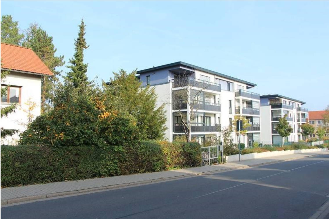
Wohnbebauung an der Edmund-König-Straße von Westen
