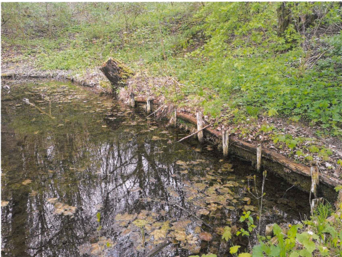
Abbildung 4: Alte Holzeinfassung des Bornteichs
